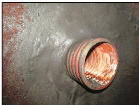
Рисунок I-6-1. Монтаж комунікаційної труби з гільзою типу «бетон-гільза»
