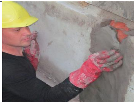
Рисунок I-5-2. Улаштування гідроізоляції примикань збірних елементів
