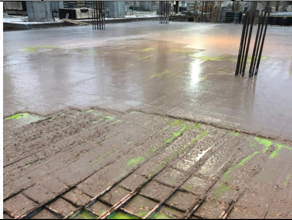
Рисунок I-1. Бетонування монолітних конструкцій промислових будівель
