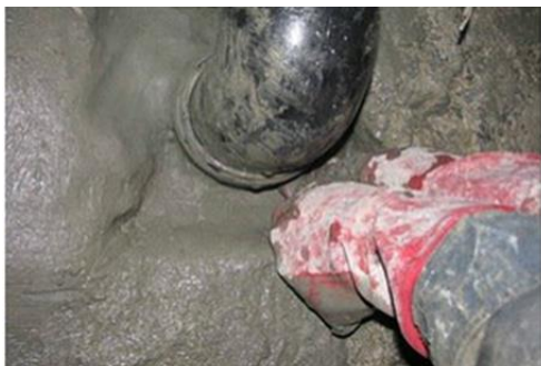
Рисунок П-4-2. Улаштування гідроізоляції місць вводу комунікацій
