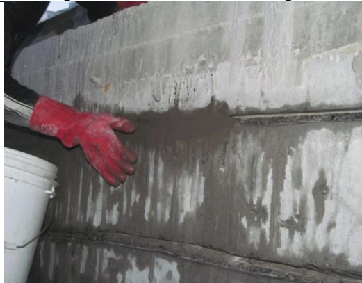
Рисунок I-5-1. Улаштування гідроізоляції стиків збірних елементів
