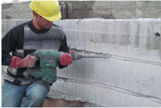
Рисунок II-2-1. Підготовка штроб для гідроізоляції збірних блоків
