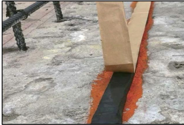
Рисунок I-2. Монтаж бентонітового джгута Penebar вздовж шва бетонування
