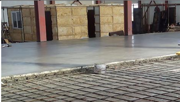
Рисунок I-15-1. Улаштування промислової підлоги
