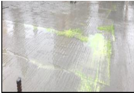
Рисунок II-1-1. Улаштування гідроізоляції плити
