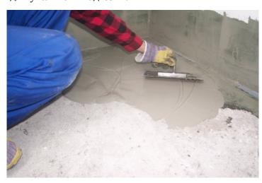
Второй и последующие слои наносить терком или с помощью шпателя. Минимальная толщина полной гидроизоляции в зависимости от применения должна составлять 2-3 мм. Нагрузка на свежую поверхность возможна согласно см. «Технические данные».
